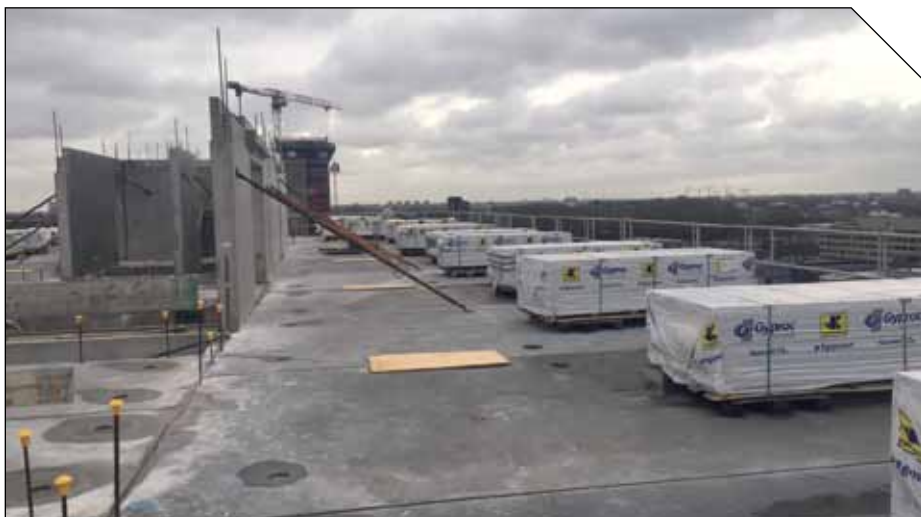
Optimale logistiek: de pallets worden geplaatst voordat de bouwlaag wordt gesloten.
