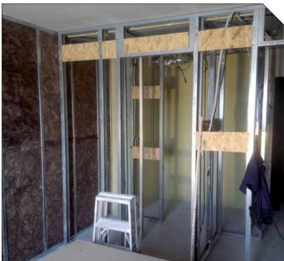
Samenwerking: in de wanden zijn reeds voorzieningen voor de diverse installaties opgenomen.
